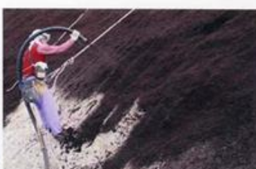
④団粒化剤水溶液を合流させて吹付け
