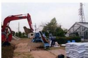
③発生土を基材調整プラントへ投入
